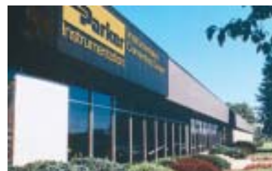
計装用コネクタ工場 (米国アラバマ州ハンツビル)
